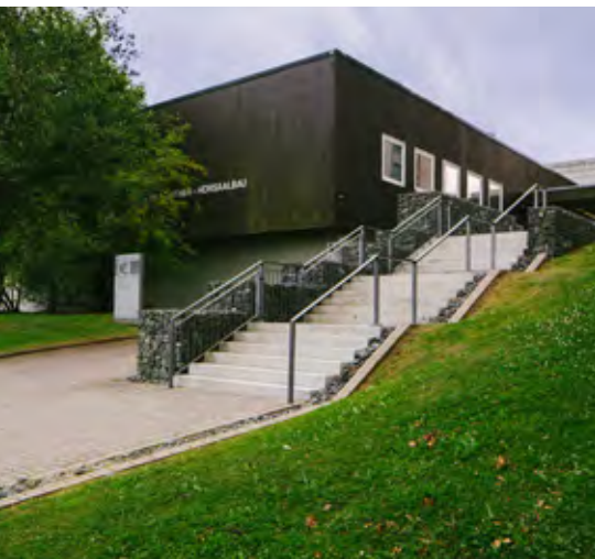
Wird saniert: der Horst-Luther-Hörsaalbau.
